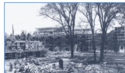
finlandais, Victor Nymark, dirigea le chantier qui, au plus fort de la construction, regroupait 3 500 ouvriers.
